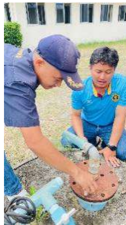
การดำเนินงานด้านการปรับปรุงบำบัดน้ำบาดาลของสถานพินิจจังหวัดชลบุรี
