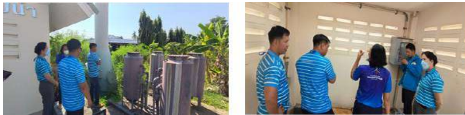
การดำเนินงานด้านการปรับปรุงบ่อน้ำบาดาลของศูนย์ฝึกและอบรมเด็กและเยาวชนหญิงบ้านปรานี
